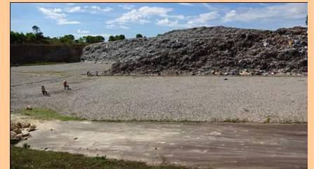
Bãi chôn lấp Thủy Phương
